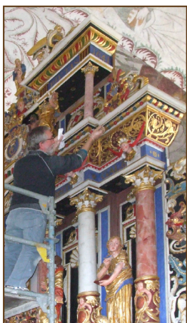
Rensning af altertavle, udført fra stillads.
